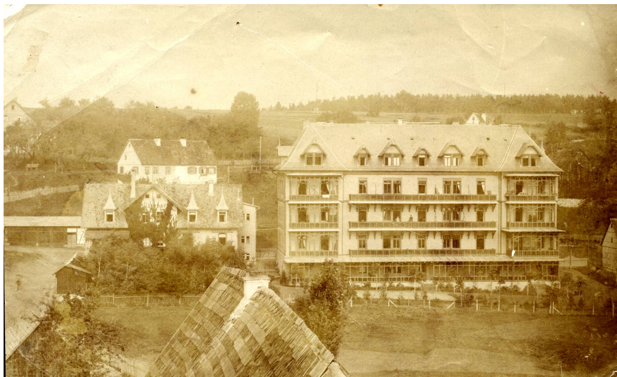
Links das Luftkurhaus, rechts der Westbau
